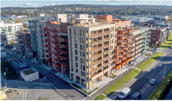
Dette er byggetrinn seks av totalt sju byggetrinn som er fullført av tospannet OBOS Nye hjem og Veidekke Entreprenør. Foto: Sindre Sverdrup Strand
